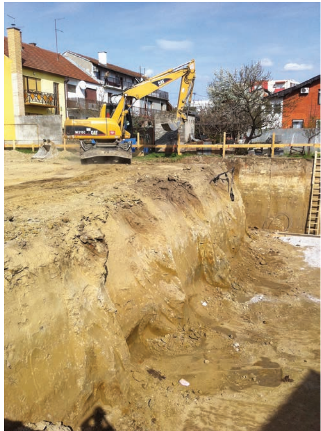
Građevna jama za stambenu zgradu na uglu Strossmayerove i Čičarijske u Osijeku
