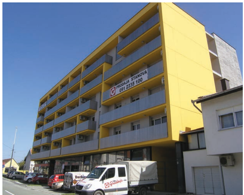
Izgled zapadnog pročelja
