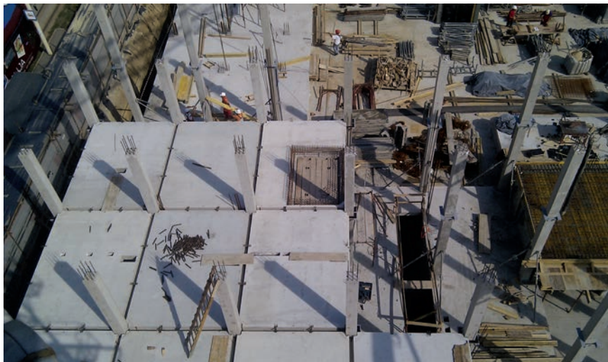
Montaža stupova i stropnih ploča
