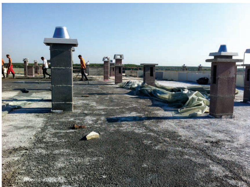
Radovi na krovu nove zgrade
