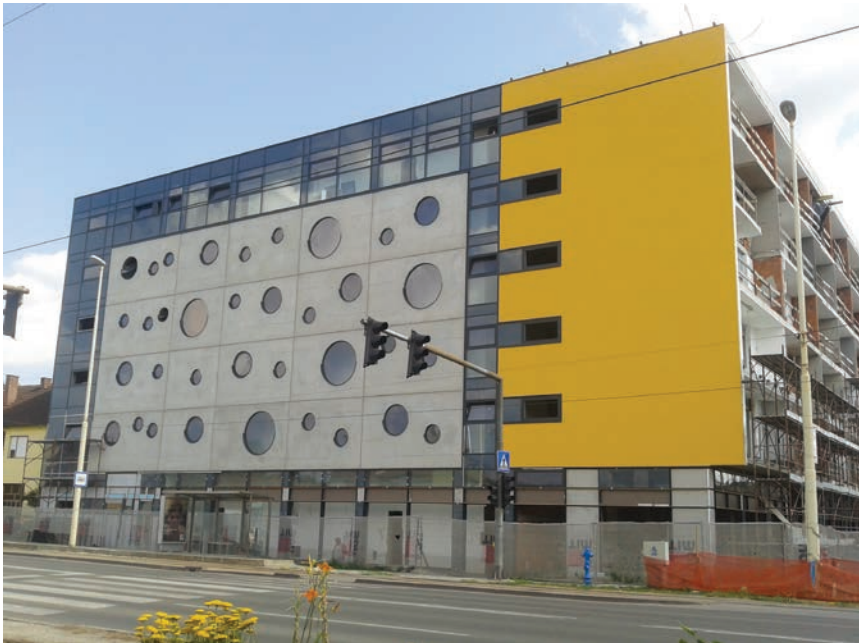
Zgrada sa završenom montažom i pročeljem
